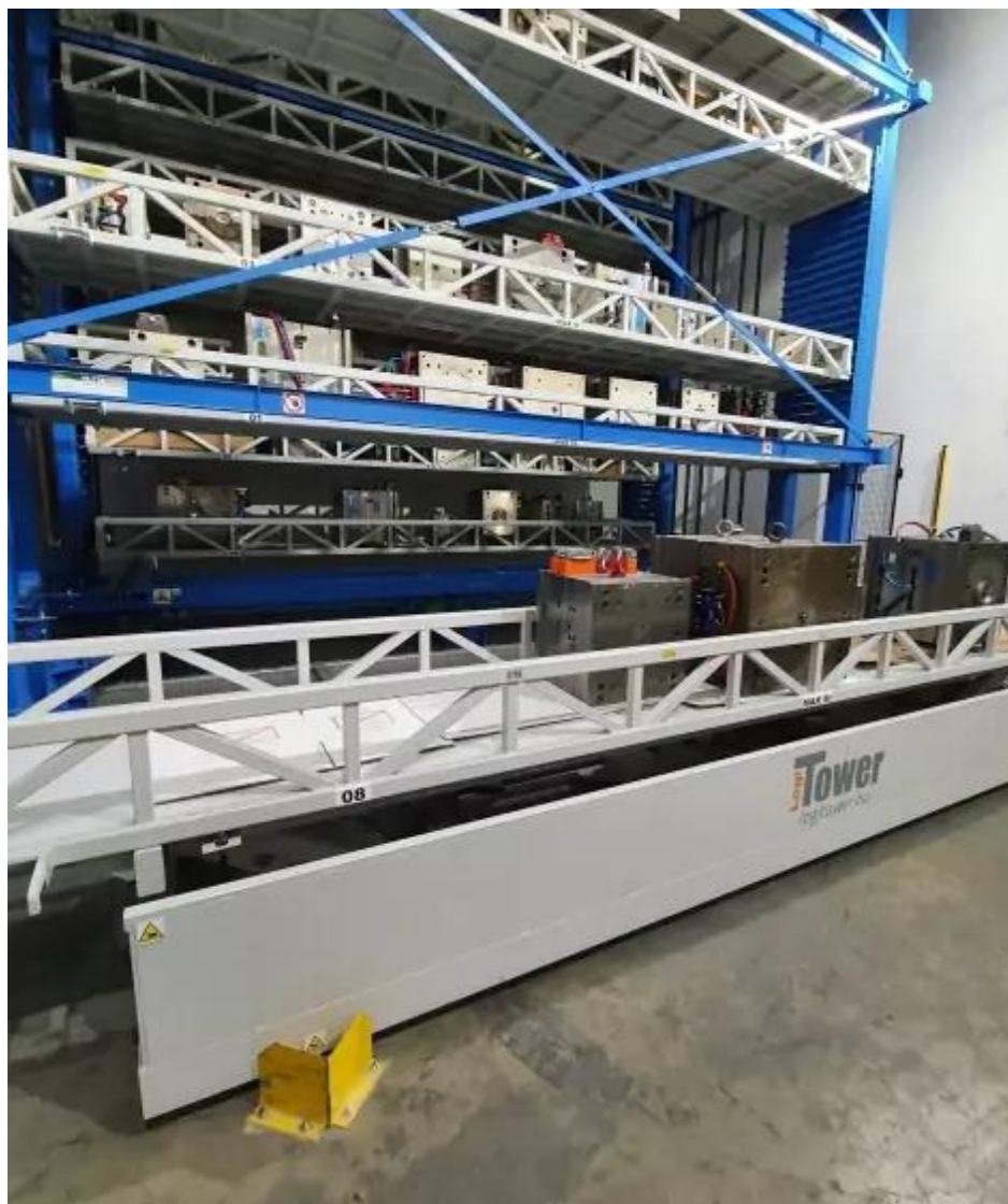
STOCKAGE PIÈCES VOLUMINEUSES
